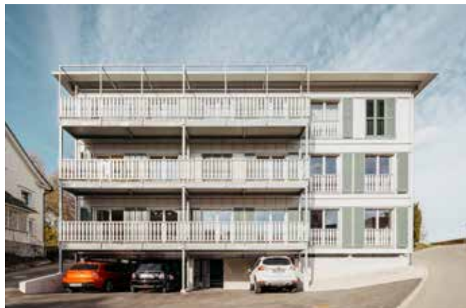
Les modules en bois offrent de grands volumes dans un espace réduit
