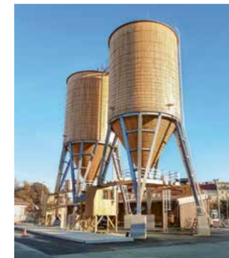
Deux silos en bois rond d'une capacité de 500 m 3 chacun dans la ville de Vienne.
