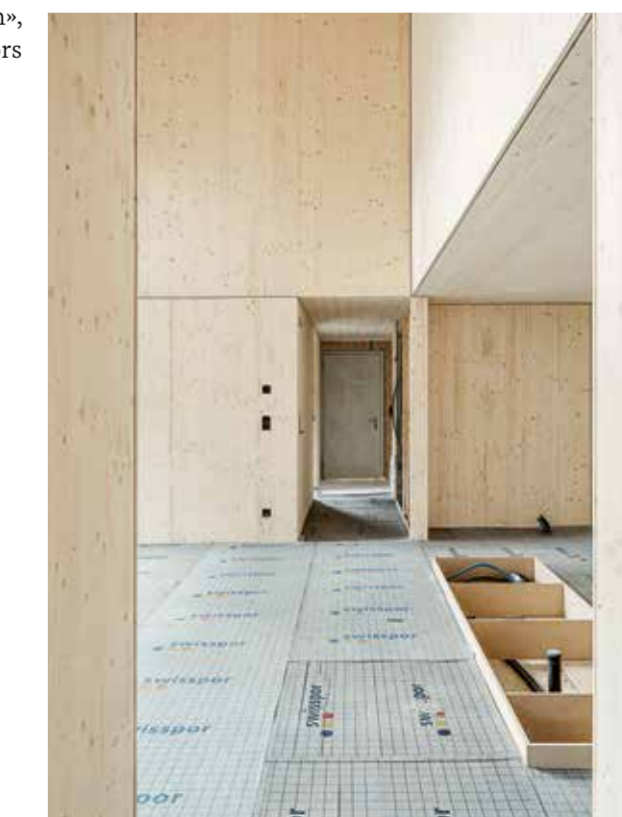
Des panneaux 3-plis en épicea prédominent l'aménagement intérieur.
