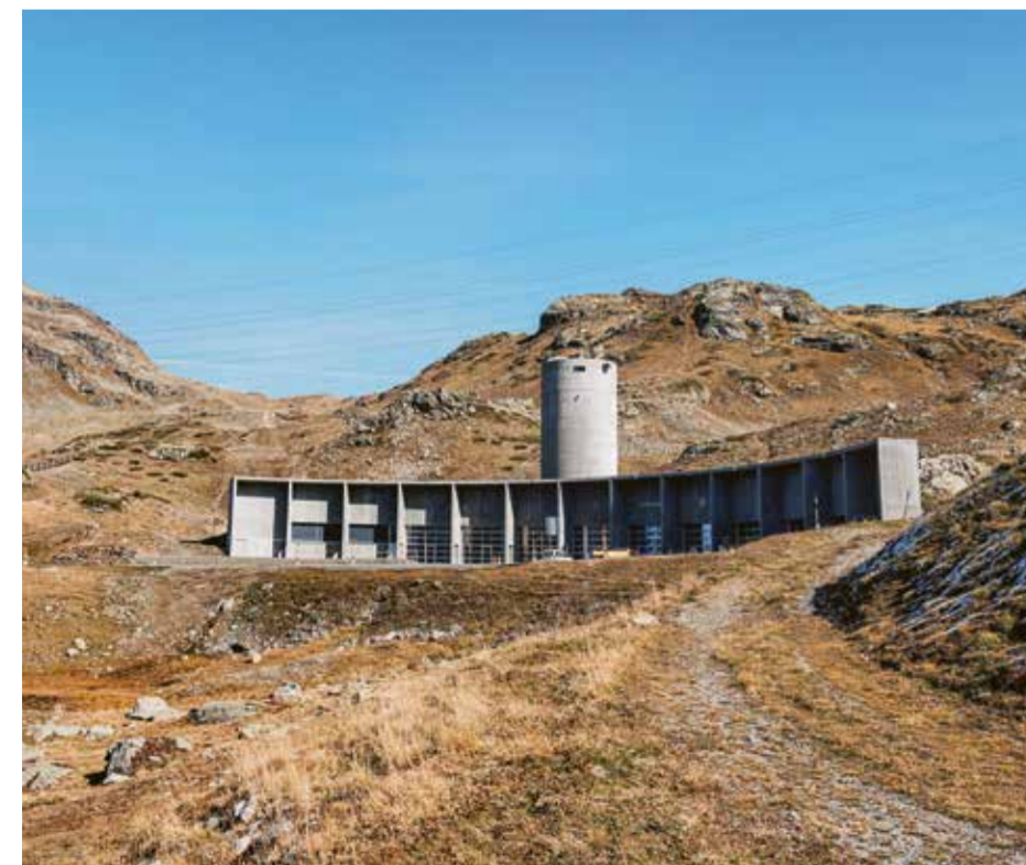
En haut: grâce à sa construction de forme semi-circulaire, la base d'entretien s'intègre parfaitement au compartiment de terrain existant.
