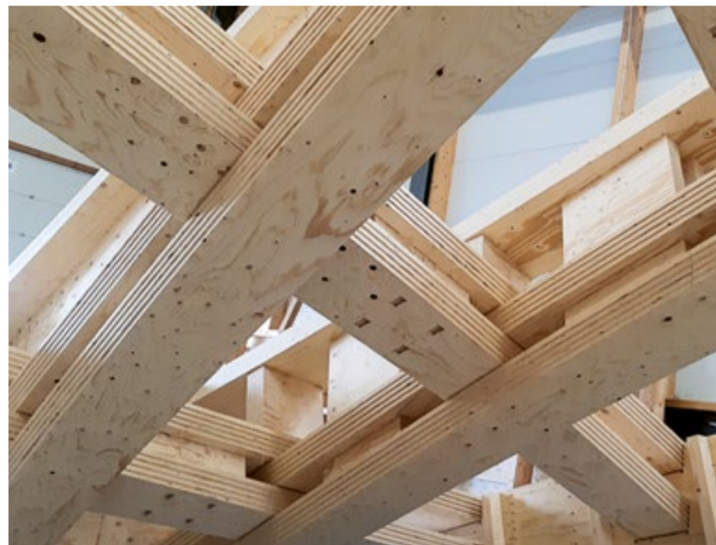
La maquette a permis d'instaurer un climat de confiance - avec le maître d'ouvrage, les fournisseurs et au sein de notre équipe de projet et de montage. Bien visibles: les cinq couches de poutres, composées chacune de cinq lamelles LVL. Les chevilles de cisaillement qui relient les couches porteuses sont également apparentes.
