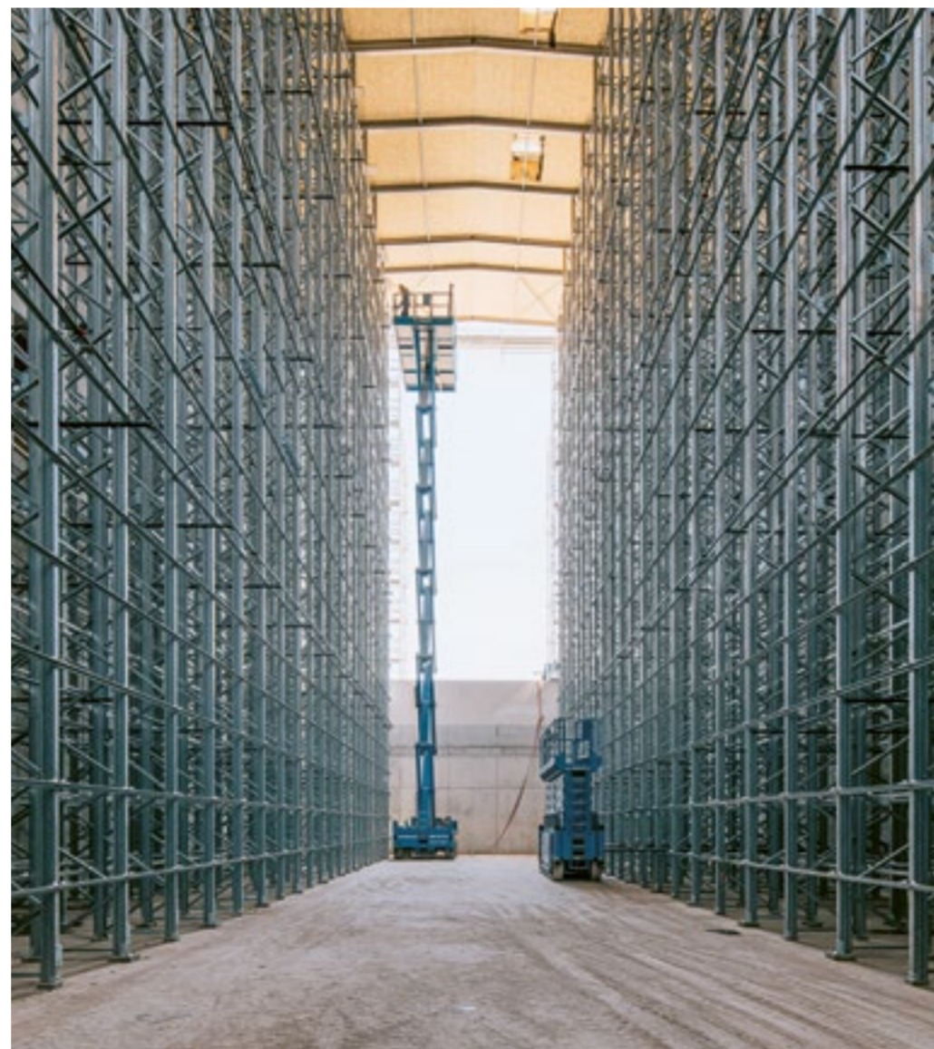
Le nouvel entrepôt à hauts rayonnages offre des possibilités de stockage supplémentaires et optimise la logistique ainsi que la transformation du bois de sciage.
