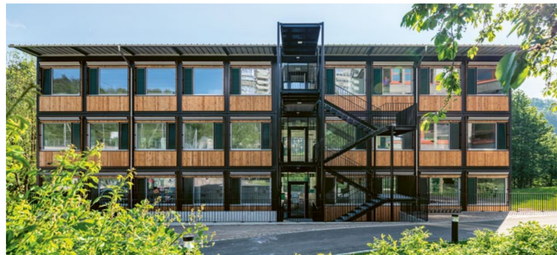
Pavillon scolaire ZM10, Sihlweid Zurich
