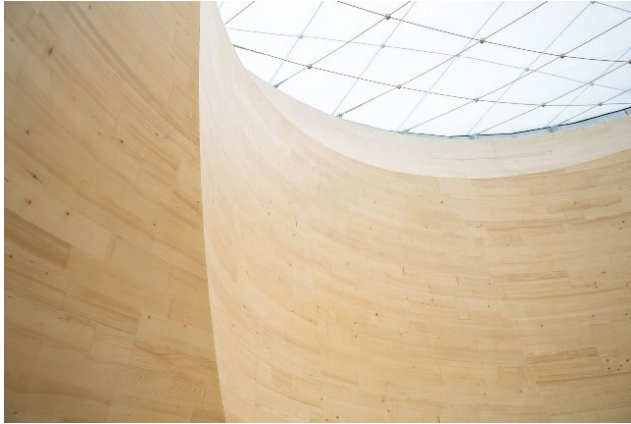
Das Oberlicht in Leichtkonstruktion aus ETFE-Folienkissen sorgt für Tageslicht im Atrium Photocredit: Jan Thoma | Blumer Lehmann
