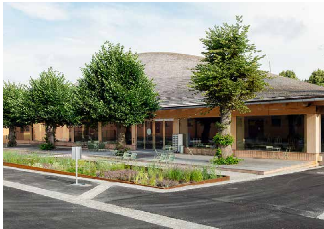
Das stützenfreie Free Form-Dach mit sichtbarer Gitterschalensystemkonstruktion aus LVL-Holz überspannt eine Fläche von 25×48 m.
