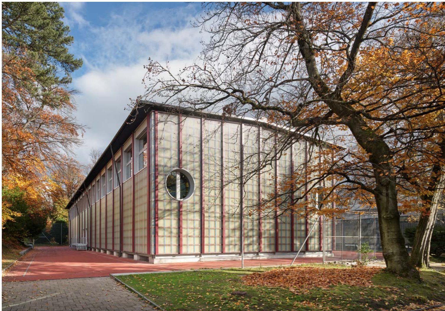
Die provisorische Sportanlage der Kantonsschule Enge stellt den notwendigen Raum zur Verfügung, bis der geplante Neubau bezugsbereit ist.
