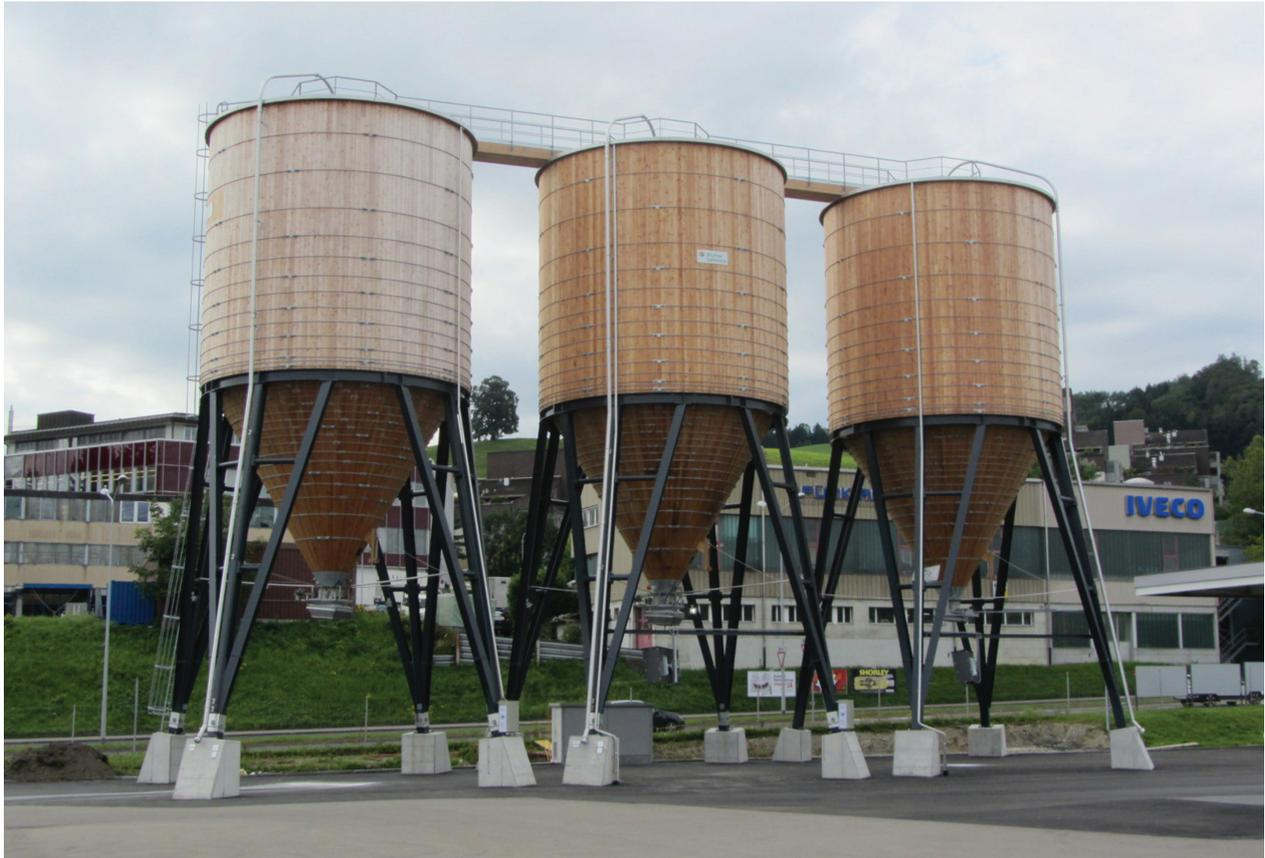
Zwei dieser drei Grosssilos sind mit Topautomatik ausgerüstet. Dies bedeutet, dass der Verladevorgang vollautomatisiert ist und mit der Verwiegung der Silos verbunden ist.
