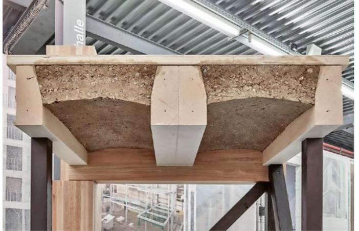
In Zusammenarbeit mit ZPF Ingenieure haben Herzog & de Meuron ein Deckensystem aus rechteckigen Holzelementen und Stampflehm entwickelt. Laut eigenen Angaben verursacht das neue Deckensystem zehnmal weniger CO<sub>2</sub>-Emissionen als eine konventionelle Flachdecke aus Beton.
