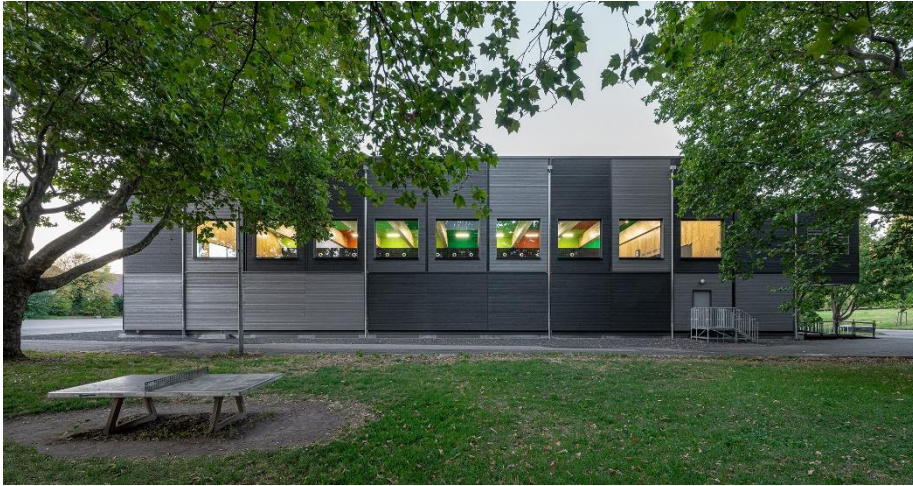
Südwestansicht mit Einblick in die Badehalle im ersten Obergeschoss
