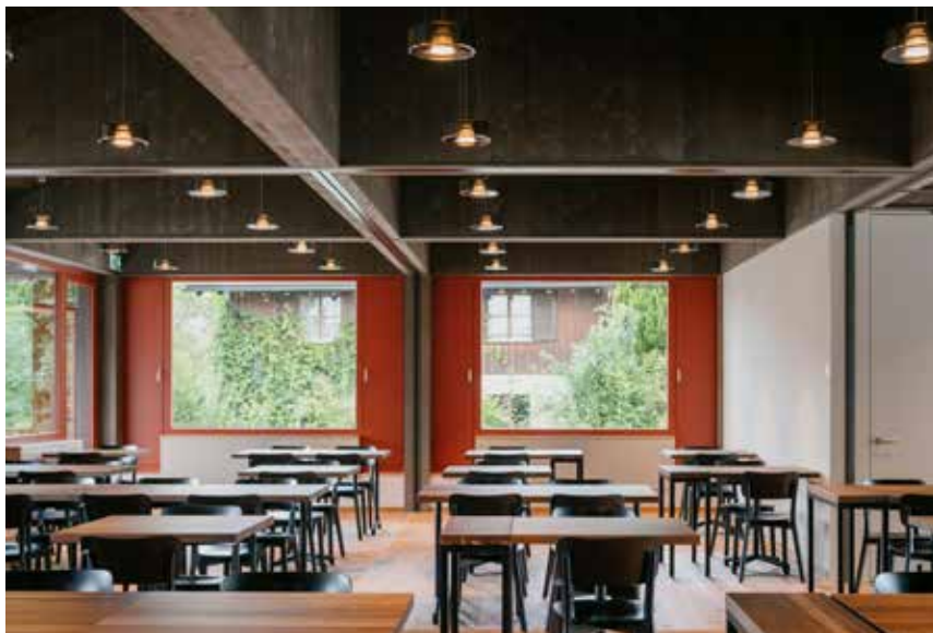
Das quadratische Deckenraster mit mobilem Trennwandsystem ermöglicht eine flexible Unterteilung in kleinere Räume.
