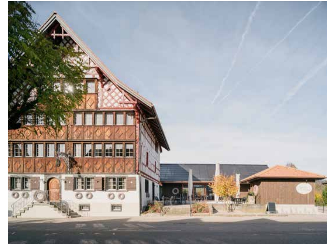
Der prachtvolle und unter Denkmalschutz stehende Altbau von 1730 wurde saniert. Die ehemalige Laube musste weichen und ist durch den rechtwinklig zum Gasthaus gelegenen Neubau ersetzt worden.
