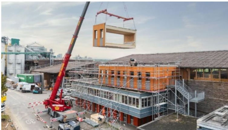
Gelebte Kreislaufwirtschaft: Rückbau des Bürogebäudes am Hauptsitz in Gossau, Schweiz.
