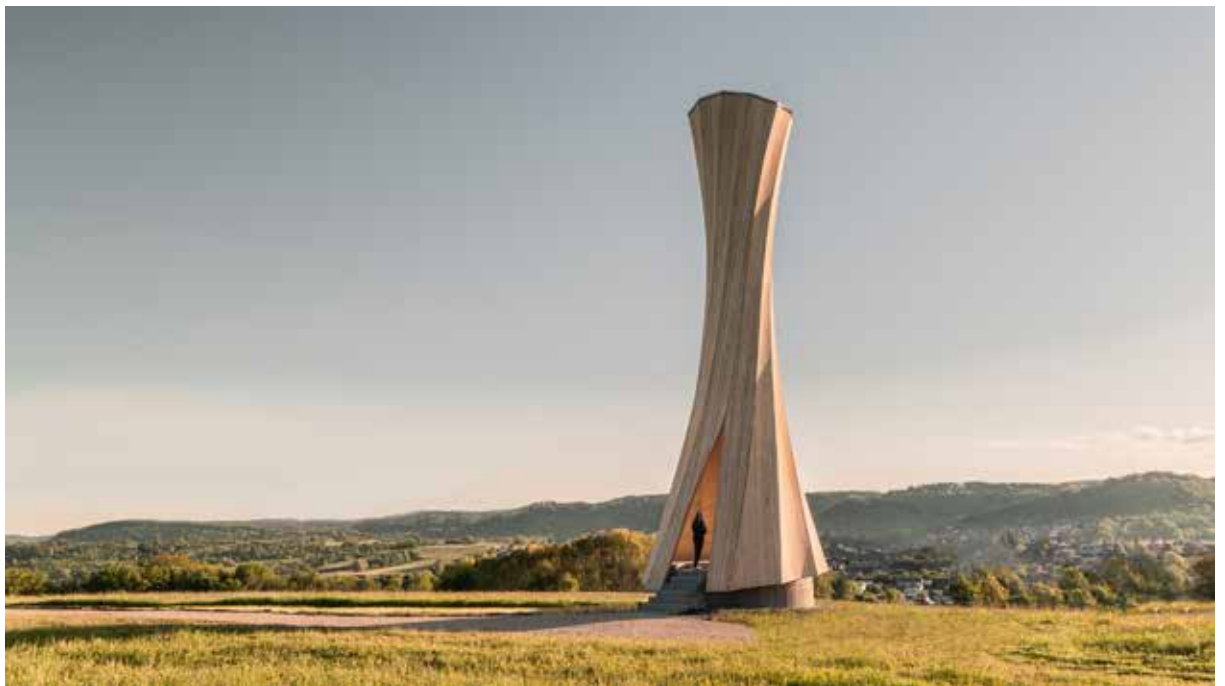
ICD UND ITKE UNIVERSITÄT STUTTGART (DE), 2019, URBACH TOWER, URBACH (DE) | ICD ET ITKE UNIVERSITÉ DE STUTTGART (DE), 219, URBACH TOWER, URBACH (DE)
