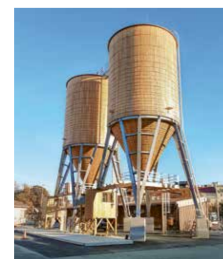
Zwei Rundholzsilos in Wien Stadt mit je 500 m 3 Fassungsvermögen.
