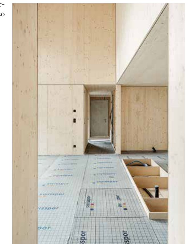
Fichten-Dreischichtplatten bestimmen den Innenausbau.
