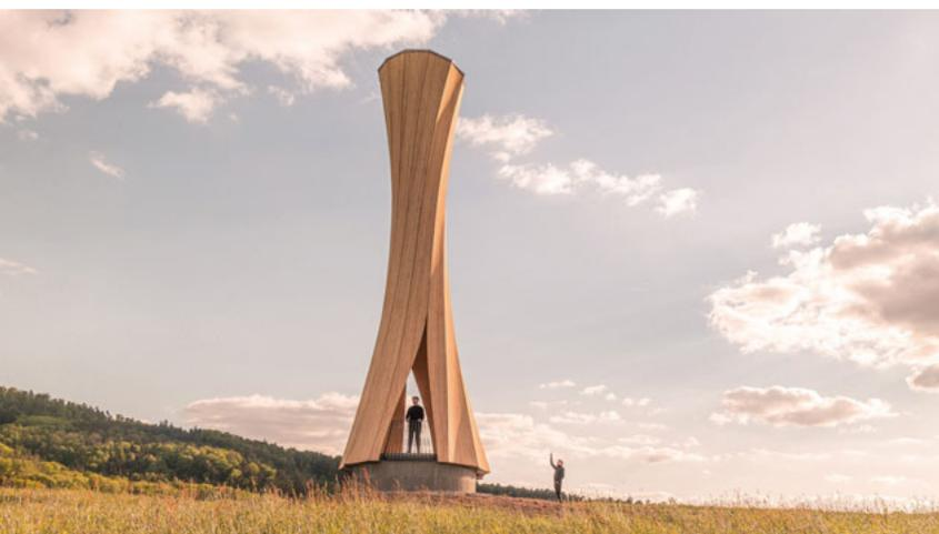
Der 14 Meter hohe Urbach-Turm besteht aus zwölf Fichtenholzpaneelen, die wiederum aus mehreren fünf Meter langen Bilayern aufgebaut sind. (Foto ICD/ITKE, Universität Stuttgart)
