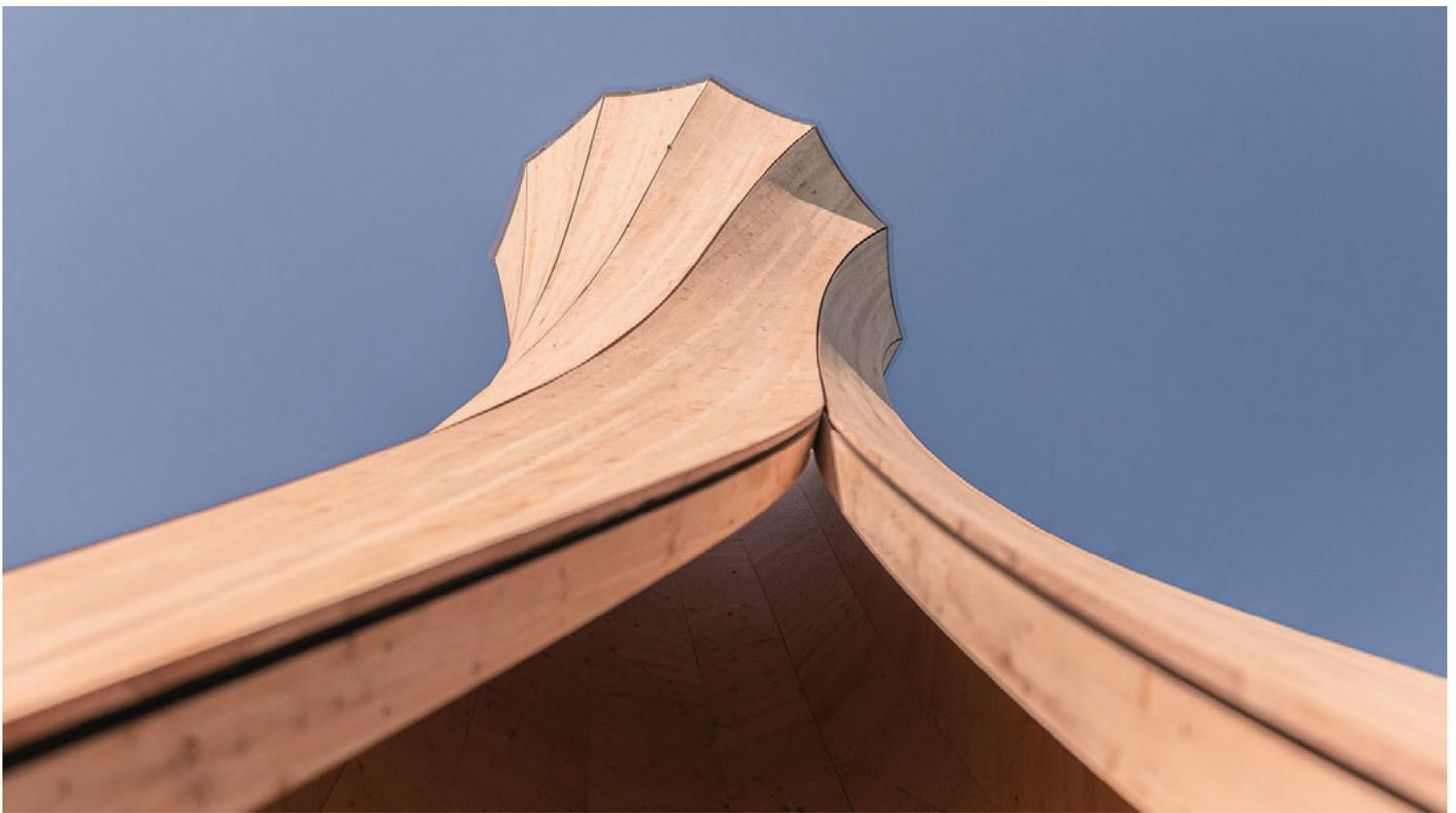
Bauelemente aus Holz, die sich selber biegen und krümmen, könnten dem Holzbau zusätzlichen Schwung verleihen. Im Bild: Urbach-Turm (Foto ICD/ITKE, Universität Stuttgart).
