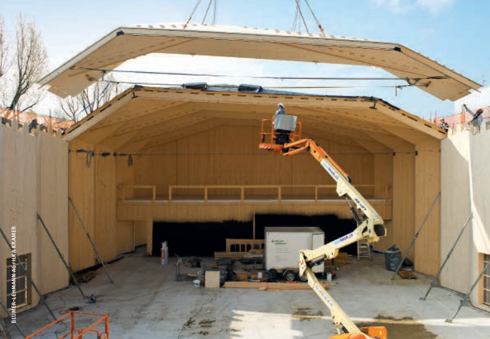
◀ Ein Deckenelement ist rund 20 Meter lang
