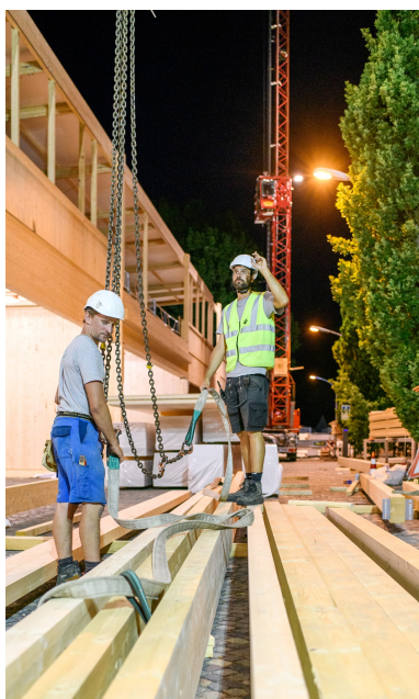
Montage Holzbau in Rekordzeit
