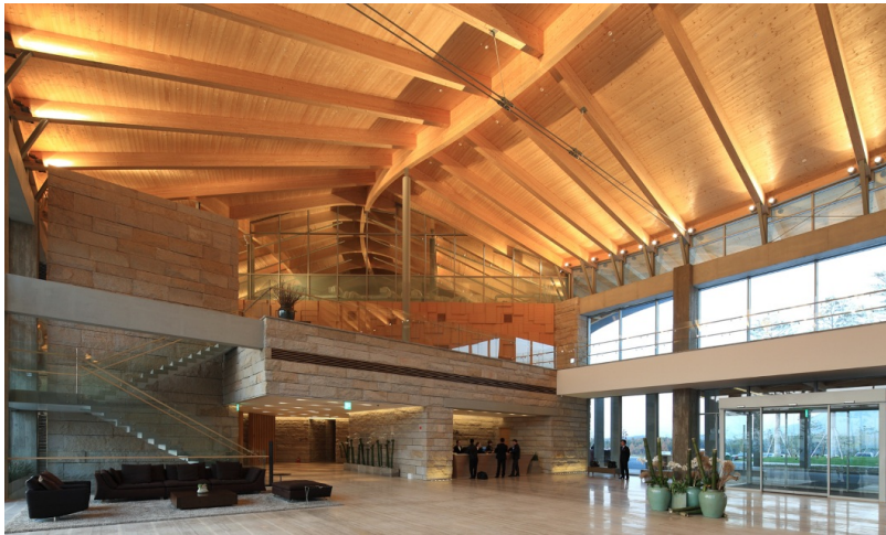
Geschwungene Dachkonstruktion in Blattform
