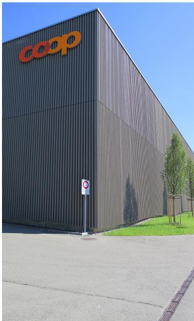
Insgesamt 3500 m<sup>2</sup> Fassadenelemente aus Douglasienholz wurden in unserem Werk vorbereitet und montiert
