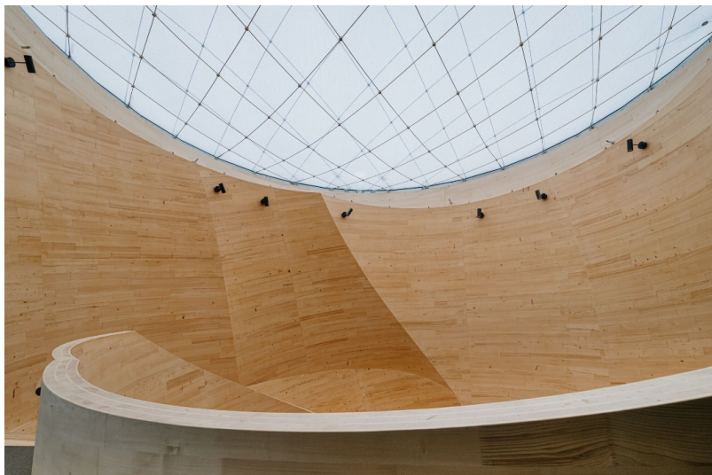
Das Oberlicht in Leichtkonstruktion aus ETFE-Folienkissen sorgt für Tageslicht im Atrium
