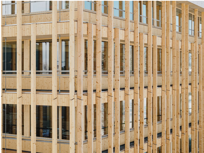
Vorgehängter Fassade aus vertikalen Holzlisenen
