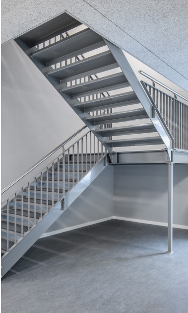
Treppen aus Metall erschliessen die drei Geschosse im temporären Schulhaus.
