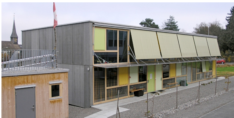
Grossflächige Fensterfronten mit Beschattungssystem
