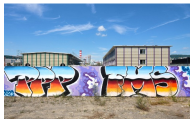
Schule in Holzmodulweise im städtischen Umfeld
