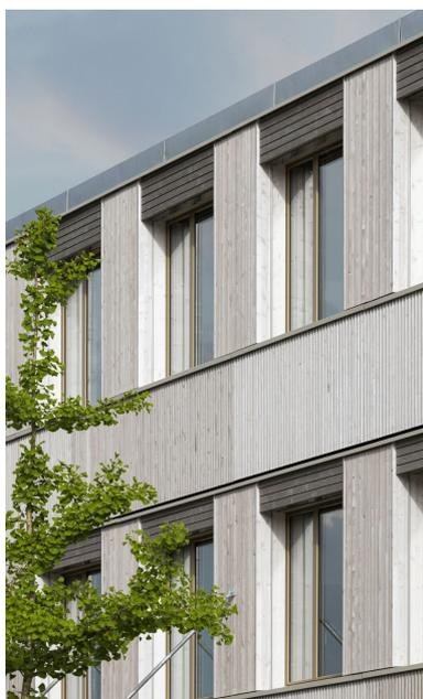
La conception extérieure du bâtiment modulaire de quatre étages se caractérise par une façade en bois, composée de lattes d'épicéa/sapin prégriseées, posées verticalement et à découvert, ainsi que de profilés rhomboïdaux couchés.
