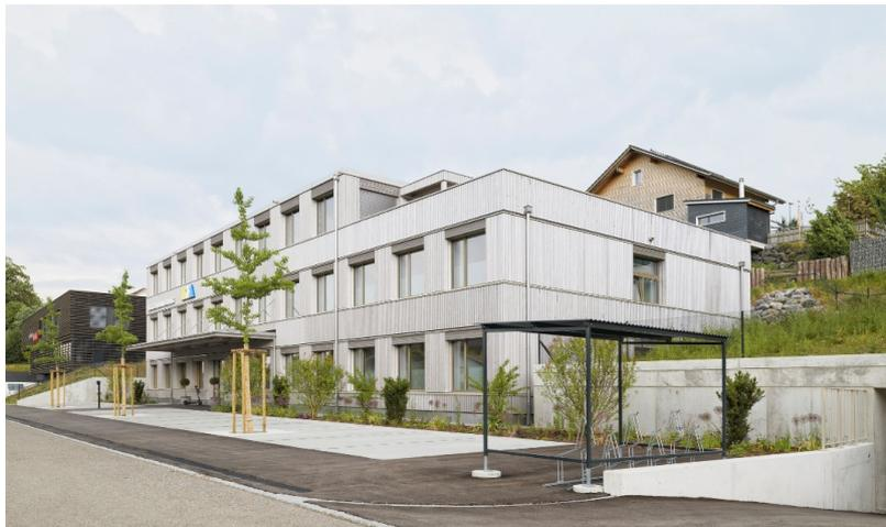
Les fenêtres, la façade en bois, les installations techniques du bâtiment, y compris les installations électriques et sanitaires, ont été prémontées dans nos ateliers de production.
