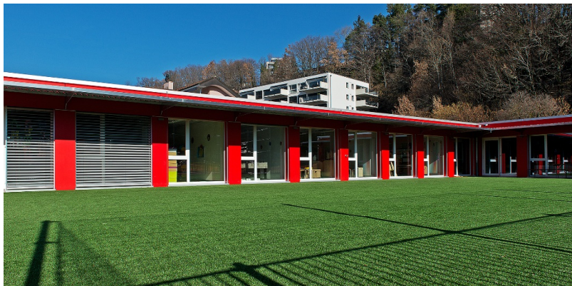
Construction modulaire de plain-pied
