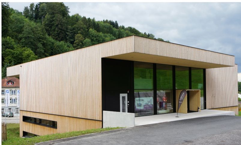
Zone d'entrée des locaux de vente
