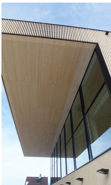
Vue d'en bas du toit
