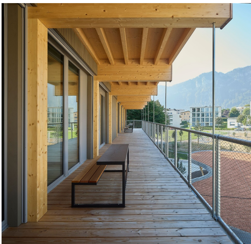
Large coursive de l'école Obermatt à Hergiswil avec structure en bois apparente, balcon périphérique et vue sur le paysage environnant. ©Marco Sieber, Luzern
