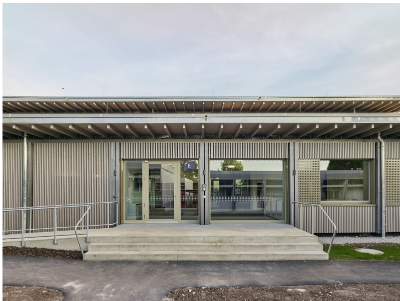
Entrée de l'école accessible aux personnes handicapées
