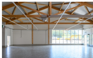
Construction en bois visible à l'intérieur
