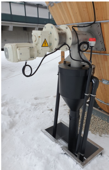
Générateur de saumure avec système de saumure et réservoir de stockage avec station de mélange
