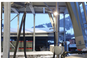
Installation mobile de convoyage électrique de retour du sel du silo à litière d'Airolo
