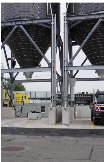
Générateur de saumure avec réservoir de stockage et réservoir de commande
