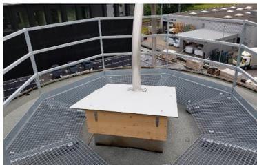
Plate-forme de toit en acier galvanisé à chaud silo rond
