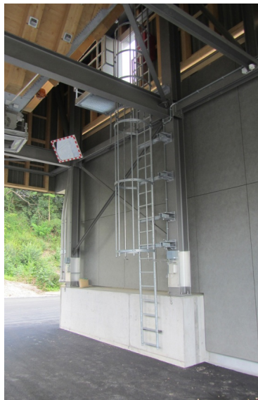
Silo modulaire double avec installation photovoltaïque
